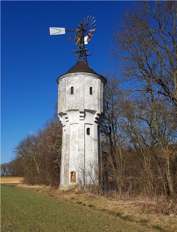
Abbildung 37: Pumpenwindrad Schönthal von Südosten betrachtet. (Foto: Butenschön 2022)
