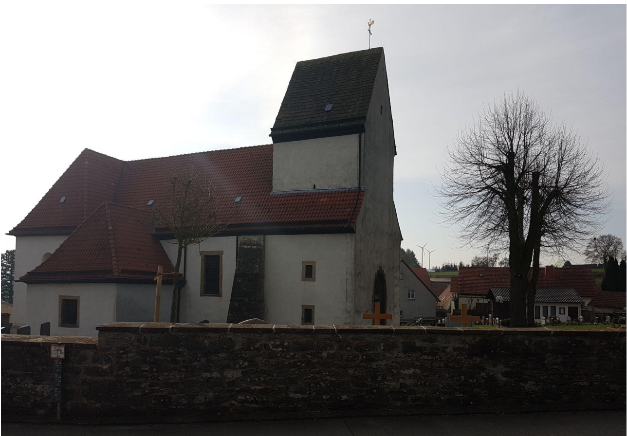
Abbildung 1: Blick auf die Pfarrkirche St. Georg, Altenheerse, von Norden. (Foto: Butenschön 2018)
