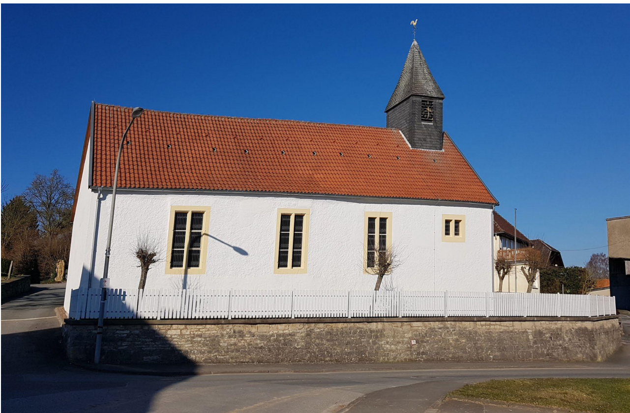
Abbildung 8: Blick auf die Pfarrkirche St. Kilian, Helmern, von Süden. (Foto: Butenschön 2022)
