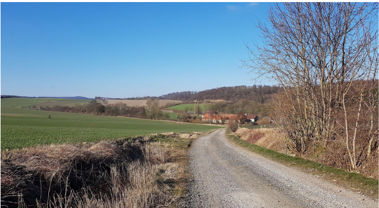
Abbildung 25: Blick von Süden auf Gut Haverhausen. Die Weiterfahrt auf diesem Feldweg in Richtung des Gutes ist untersagt. (Foto: Butenschön 2022)
