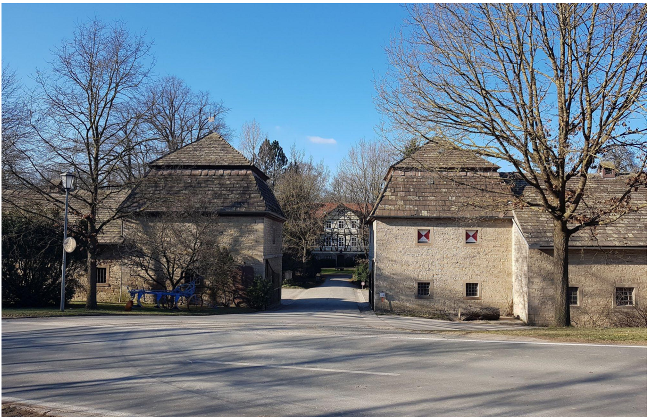
Abbildung 26: Blick auf Gut Helmern von Süden. Die beiden Torhäuser rahmen die Einfahrt. Das Gutshaus im Hintergrund ist nur im laublosen Zustand der Vegetation sichtbar. (Foto: Butenschön 2022)
