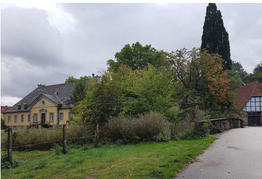
Abbildung 29: Blick vom privaten Hof auf die Nordseite des Schlosses Niesen (Foto: Butenschön 2019)
